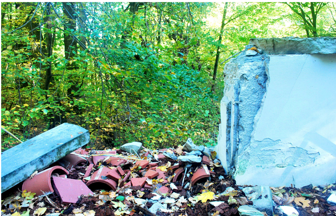
Fot.9. Zniszczony fragment prześła przy południowym słupku. Piaskowcowa nakrywa została zniszczona i wymaga rekonstrukcji. Ceramiczne wypełnienie wymaga odtworzenia brakujących kształtek. Należy zlecić wykonanie ich specjalistycznej cegielni, która będzie w stanie kształtki zrekonstruować. Zniszczony został skraj murowanego słupka i jego piaskowcowa nakrywa.
