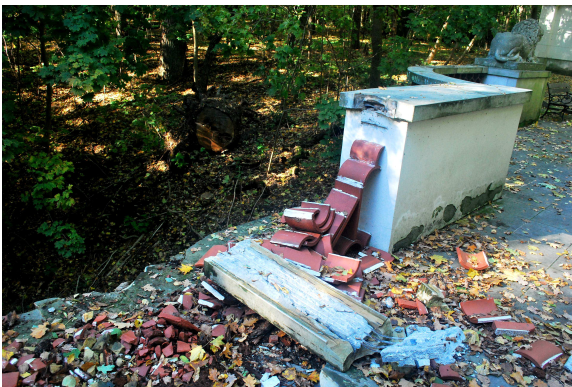
Fot. 2. – Północny skraj zniszczonego przęsła balustrady zachodniej. Przy słupku północnym przęsła widoczne ocalałe ceramiczne kształtowniki ażurowego wypełnienia balustrady. Należy je zdemontować, oczyścić z resztek zachowanej zaprawy łączącej i ponownie wbudować w trakcie remontu i odtworzenia elementów zniszczonych. Widoczna na pierwszym planie piaskowcowa nakrywa balustrady – po zrekonstruowaniu zniszczonego końca, do ponownego zamontowania w swoim miejscu.
