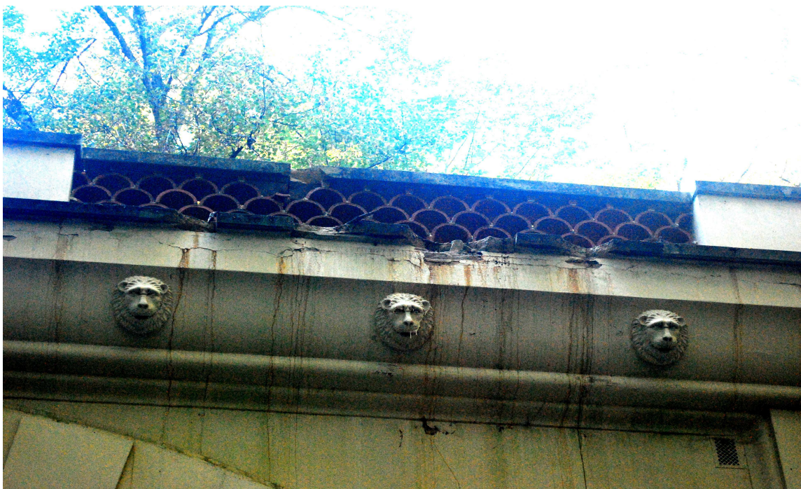
Fot.15. Widoczne uszkodzone przęsło balustrady nad arkadą przejazdu. Podczas upadku drzewa uszkodzone zostały piaskowcowe nakrywy gzymsu i balustrady. Wyłamane fragmenty nakryw kamiennych należy wyciąć wyrównując krawędzie ubytku, następnie wstawić kamienne fleki z piaskowcowej płyty o grubości i kolorystyce odpowiadającej płytom istniejącym. Struktura konstrukcji murowanej gzymsu nie wymaga interwencji. Uzupełnić należy niewielkie ubytki w warstwach tynku.
