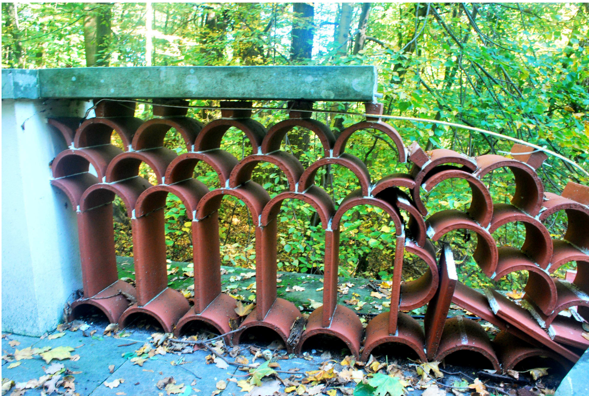
Fot.7. Widoczny zachowany fragment balustrady. Wszystkie zachowane w całości ceramiczne kształtki należy pozostawić na swoich miejscach. Te, które wskutek uderzenia rozsypały się, ale pozostały w całości nienaruszone, należy oczyścić z resztek zaprawy i użyć do odtworzenia zniszczonych segmentów.
