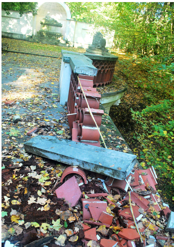
Fot.10. Fragment przęsła północny, gdzie zachowała się część balustrady z ceramicznych kształtek i leżącej na niej kamiennej nakrywie. Środkową część przęsła odbudować, wbudowując ocalałą nakrywę i ceramiczne kształtki wypełnienia.
