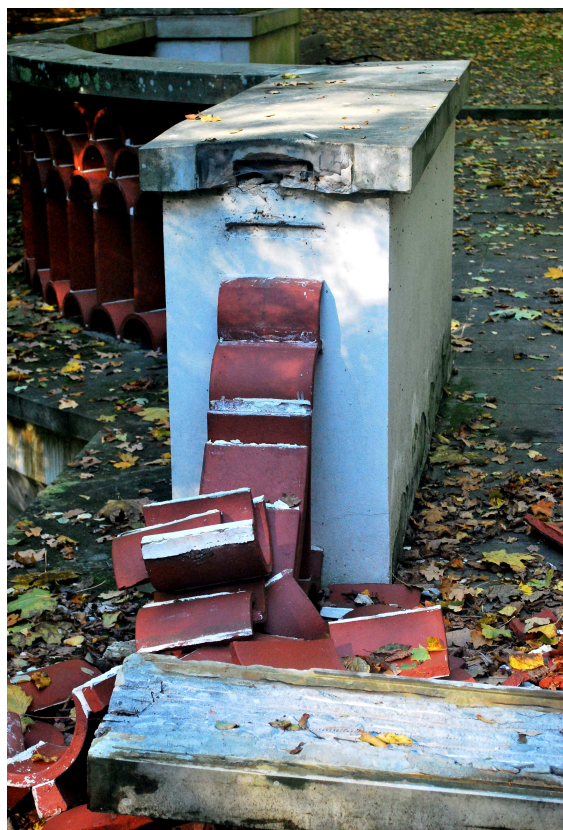
Fot. 5. – Północny skraj przęsła balustrady. Widoczne miejsce osadzenia piaskowcowej nakrywy balustrady.
