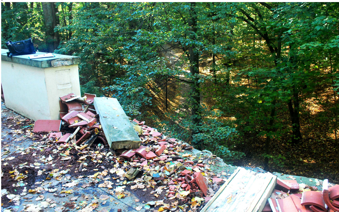
Fot.3. – Południowy skraj zniszczonego przęsła balustrady. Widoczne zniszczone ceramiczne kształtki wypełnienia balustrady. Z gruzów wydobyć kształtki zachowane w całości i po oczyszczeniu wbudować w odtwarzane przęsło. Widoczna nakrywa piaskowcowa z niewielkimi uszkodzeniami – do oczyszczenia, naprawy i ponownego montażu w przęsło. Odtworzyć należy zniszczoną, niewidoczną część nakrywy i wbudować w balustradę mostu.
