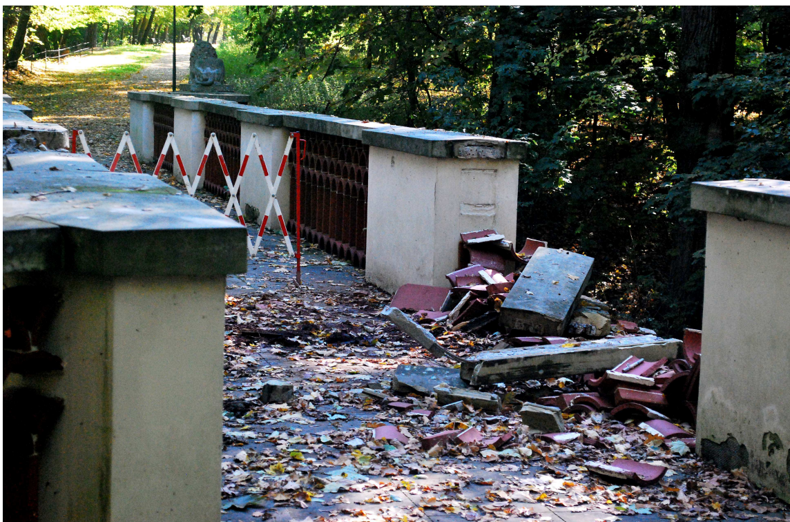
Fot. 1. – Zniszczone całkowicie przęsło balustrady zachodniej. Widoczne na posadzce mostu dwie nakrywy kamienne, które nadają się do remontu i ponownego zamontowania w swoich miejscach.
