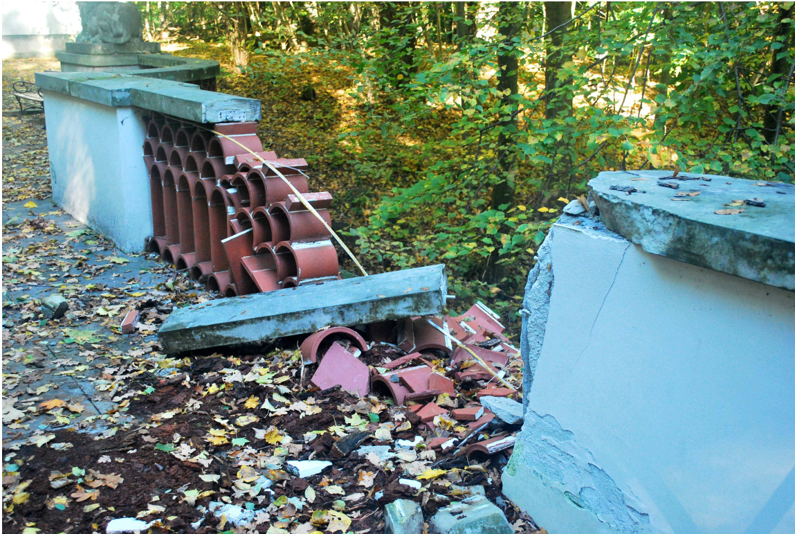
Fot. 6. Zniszczenia przęśła balustrady wschodniej. Zniszczeniu uległo 2/3 przęśła od strony południowej. Ceramiczne kształtki balustrady od strony północnej nie zostały zniszczone. Zachowała się spoczywająca na nich kamienna nakrywa.
