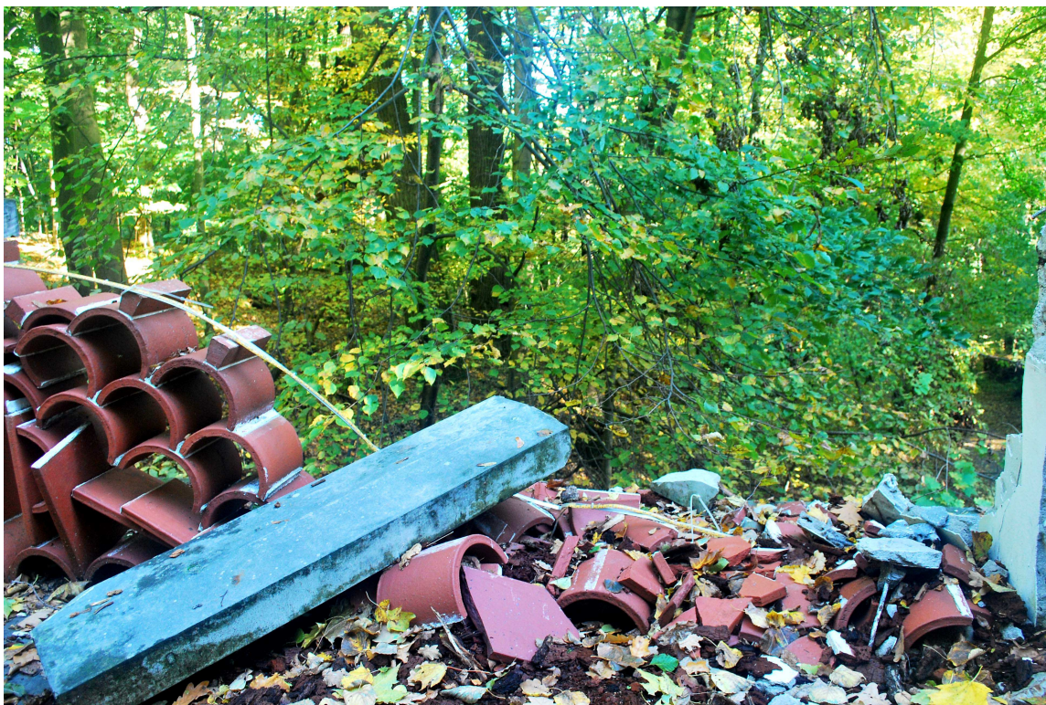
Fot.8. Tu widoczna część zniszczonego fragmentu balustrady. Na pierwszym planie – zrzucona z balustrady kamienna nakrywa. Należy ją wyremontować poprzez uzupełnienie zniszczeń w ponownie wbudować w remontowane prześło. Rozsypane pod nakrywą ceramiczne kształtki przebrać. Ocalałe w całości o0czyścić i wykorzystać w odbudowanej balustradzie.
